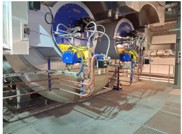
Rysunek 1 - palniki kotłów na zewnątrz
